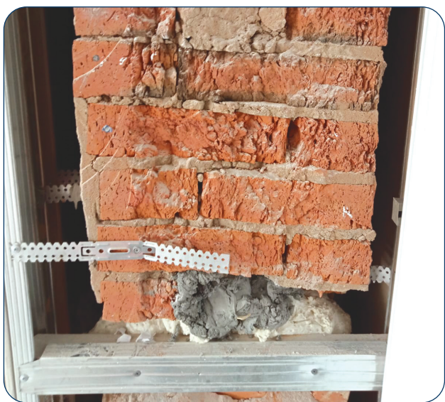
Обшивка кирпичных стен сада без обработки укрывными составами и гигантскими зазорами
