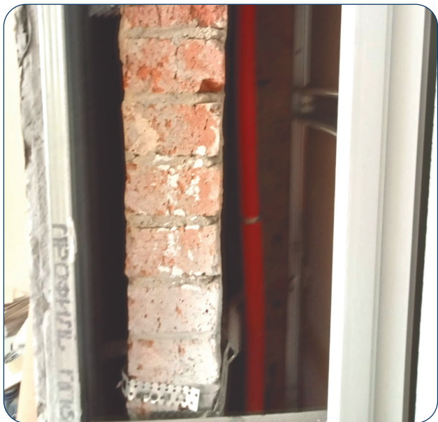
Обшивка кирпичных стен сада без обработки укрывными составами и гигантскими зазорами
